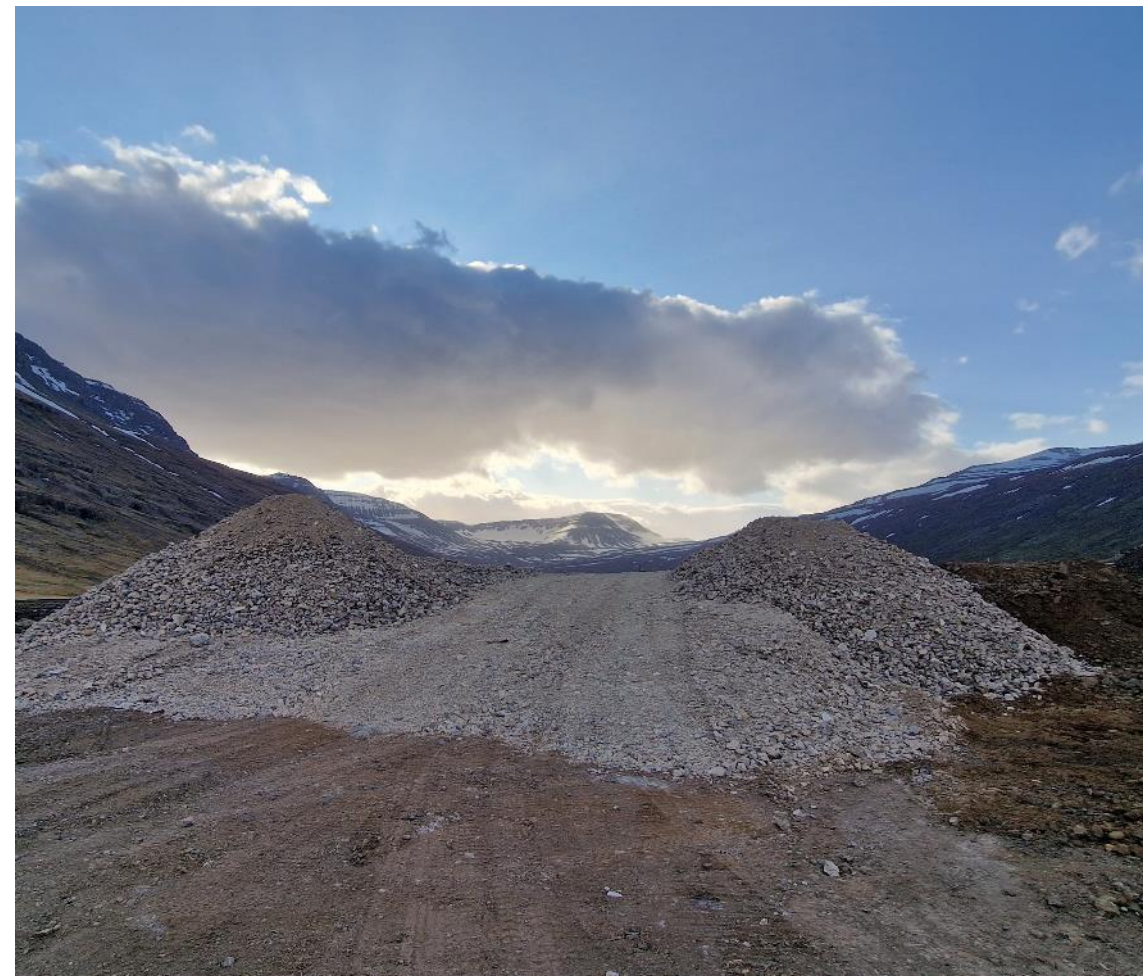
Mynd: Hér má sjá steypumulning úr gamla frystihúsinu
